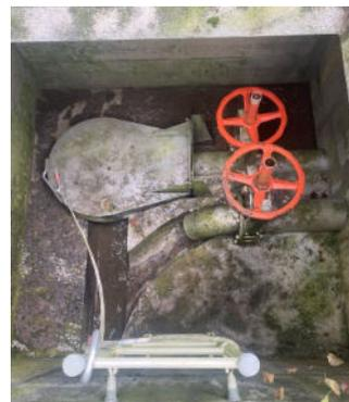
Abbildung 4: Mechanische Abflussdrosselung
